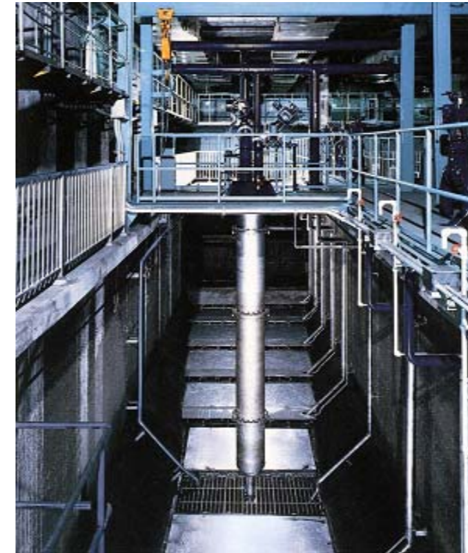
写真1 ジェットポンプの設置例(揚砂機)
