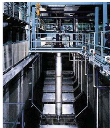
写真-1 ジェットポンプの設置例(揚砂機)
